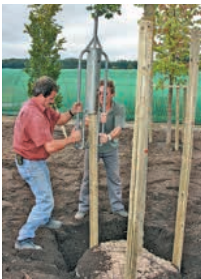
Bei der Pflanzung von Ballengehölzen werden die Pfähle nach der Pflanzung in den Unterboden gerammt, z. B. mit einem Pfahltrieb.
