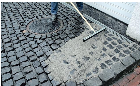
Fugenmörtel mit Gummischaber einwischen
